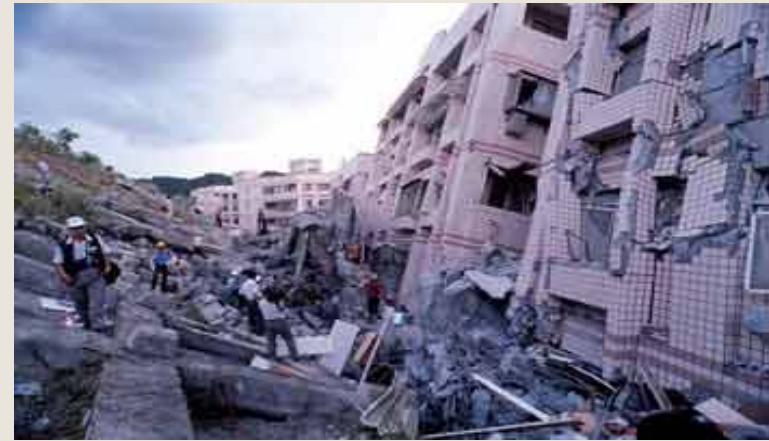
林肯大郡山坡地房屋倒塌
